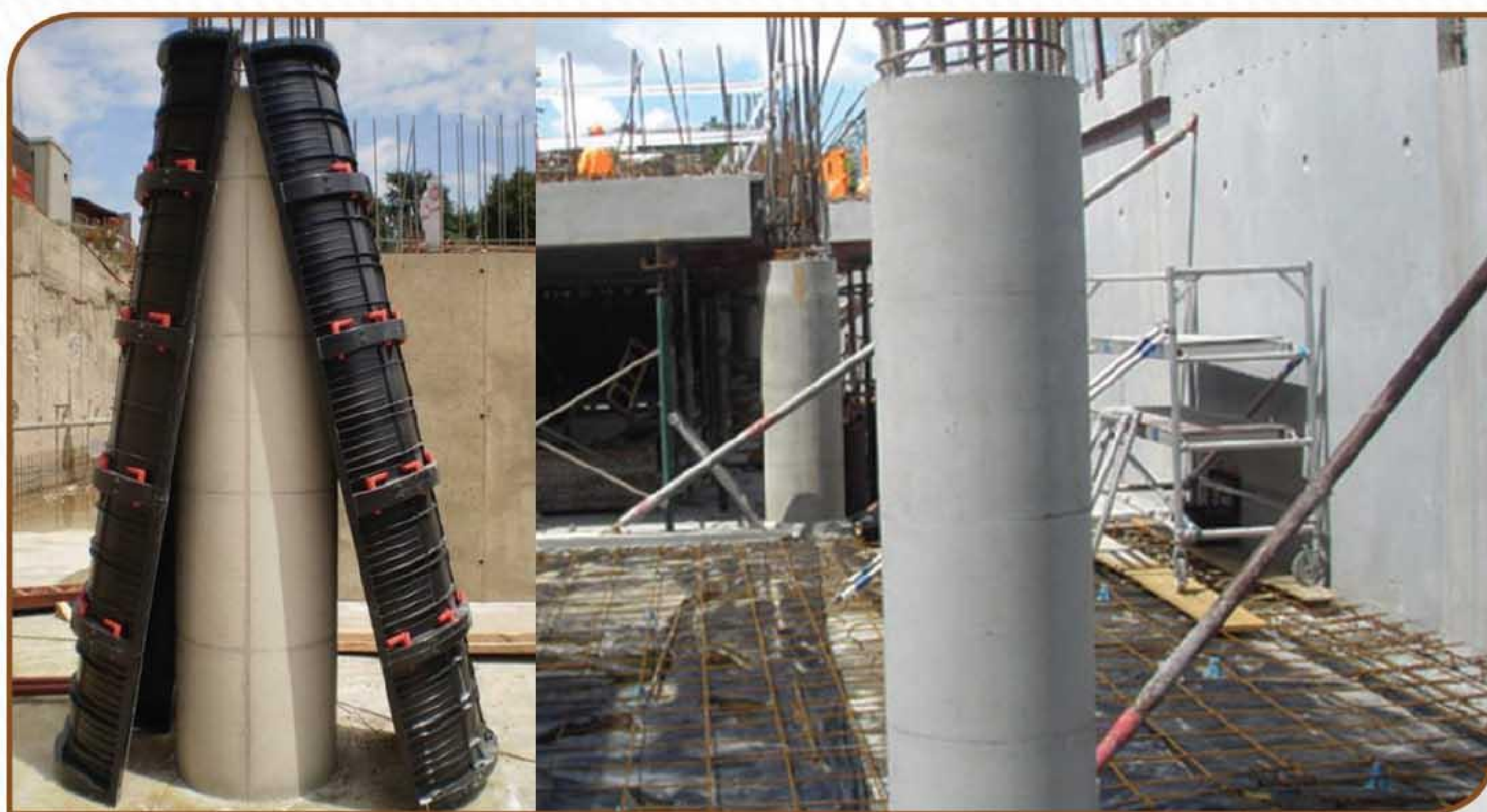
گرمایش عمرانی خشک‌کن محصولات بتنی (قالب ستون، تیر، تیرچه، بلوک و...)
